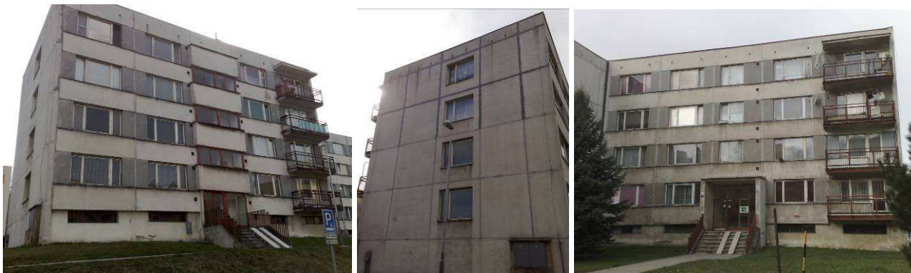
Obr.1 Pohledy na objekt z exteriéru
